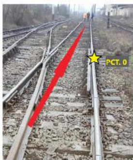
Imaginea 3- porțiunea de linie parcursă de trenul deraiat
