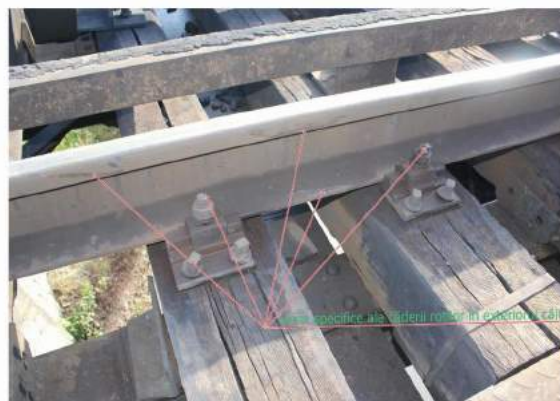
Foto 9: zona căderii roților din partea dreaptă în exteriorul căii
