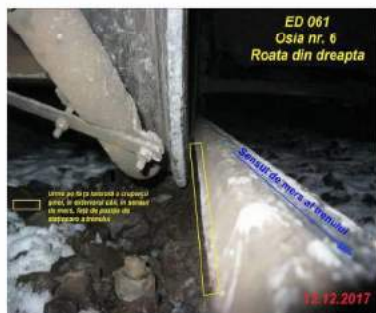
Foto nr.5 - Urme de deraiere în sensul de mers pe cca. 8,00 m de la locomotivă, față de poziția de staționare a trenului
