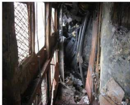
Foto nr.1 – culoar sala mașinilor
