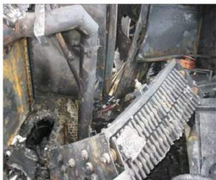
Foto nr.3 - zona TP rezistența de trecere
