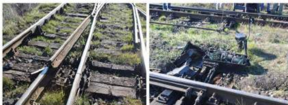
Foto 16: parte din pogubele produse la schimbătorul de cale nr. 3
