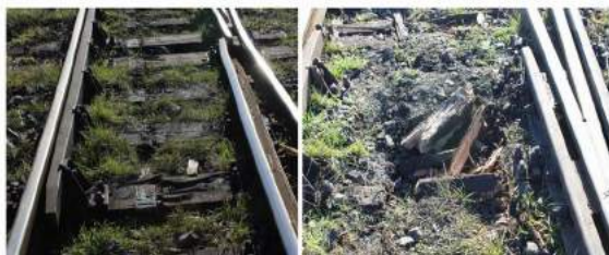
Foto 2,3,4,5: pagube produse la suprastructura căii
